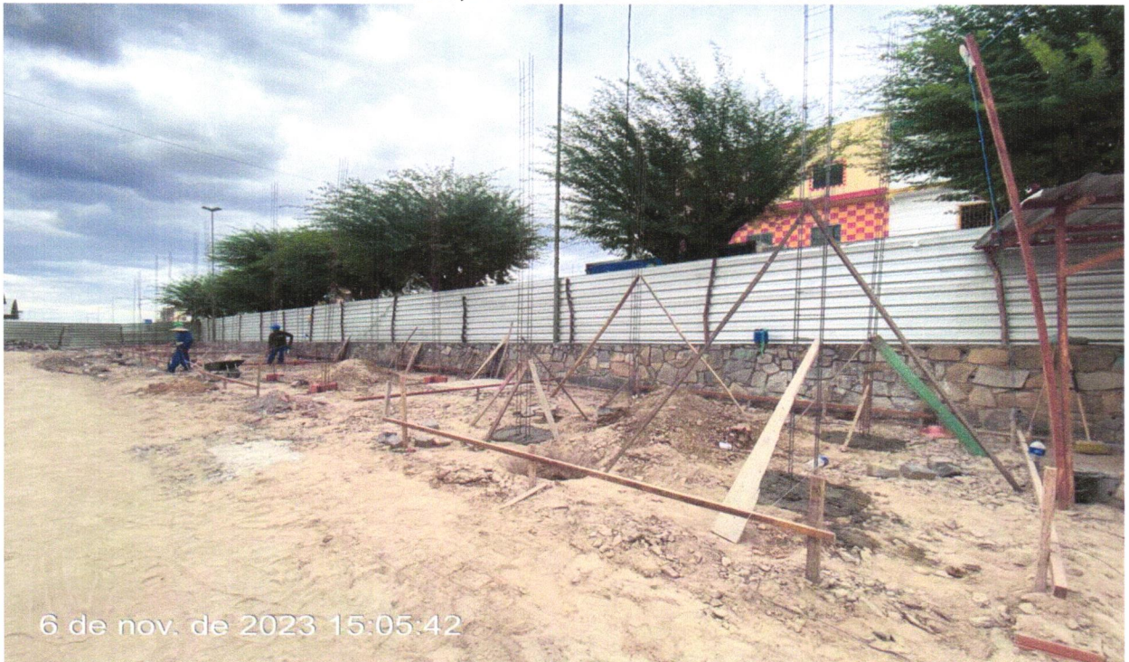
FOTO 24 - LASTRO DE CONCRETO MAGRO, APLICADO EM BLOCOS DE COROAMENTO
