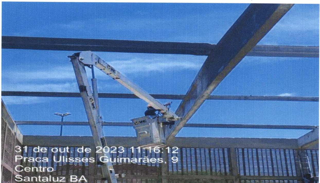
FOTO 20 - PINTURA COM TINTA ALQUÍDICA DE ACABAMENTO (ESMALTE SINTÉTICO ACETINADO) APLICADA A ROLO OU PINCEL SOBRE SUPERFÍCIES METÁLICAS (EXCETO PERFIL)
