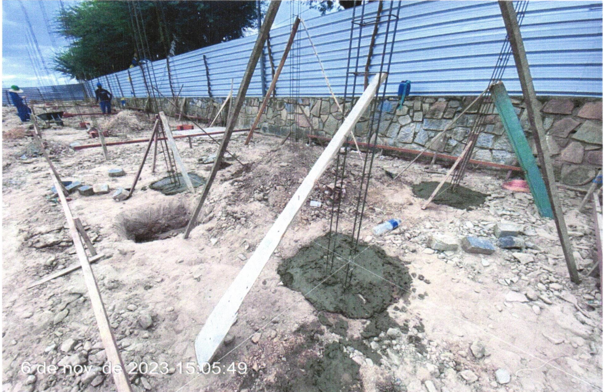
FOTO 24 - LASTRO DE CONCRETO MAGRO, APLICADO EM BLOCOS DE COROAMENTO
