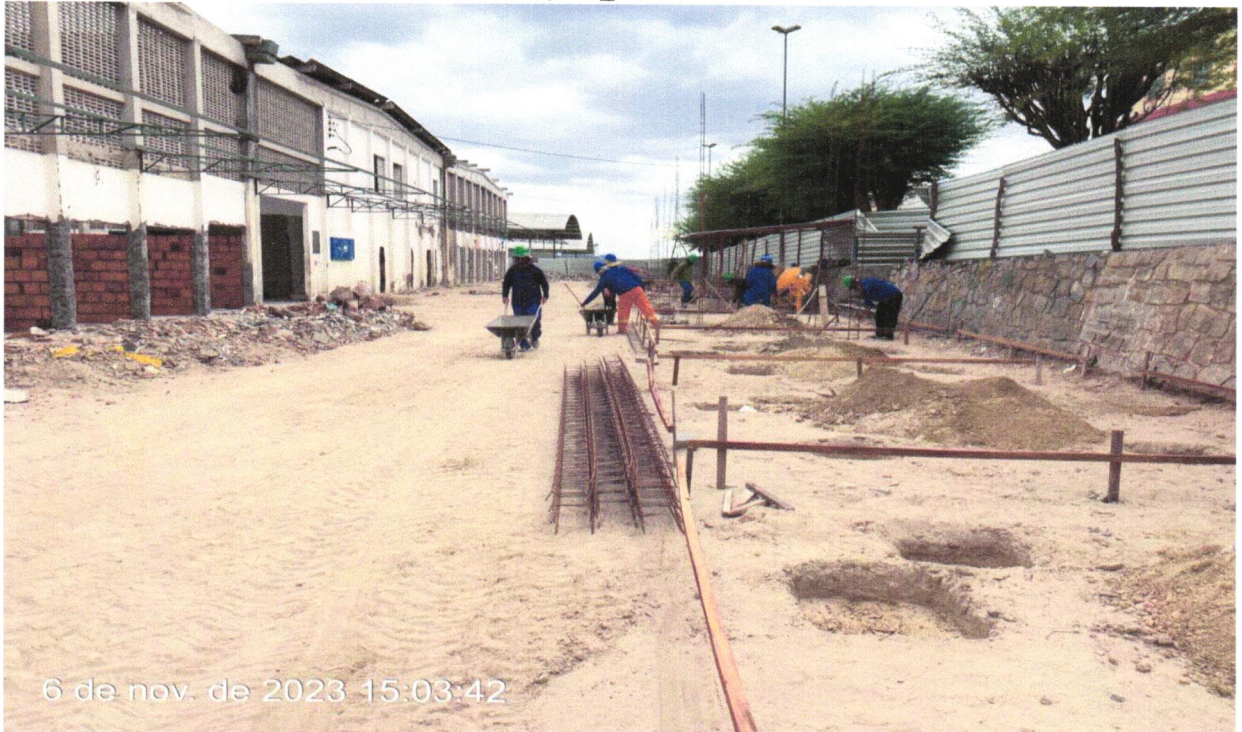
FOTO 22 - ESCAVAÇÃO MECANIZADA PARA VIGA BALDRAME COM MINI-ESCAVADEIRA (INCLUINDO ESCAVAÇÃO PARA COLOCAÇÃO DE FÔRMAS). AF_06/2017
